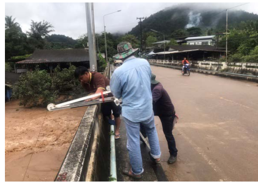
รูปที่ 5.8-4 ทำการสำรวจปริมาณน้ำและการสำรวจตะกอนแขวนลอยสถานี P.92 น้ำแม่แตง บ้านเมืองก๊ิด อำเภอแม่แตง จังหวัดเชียงใหม่
